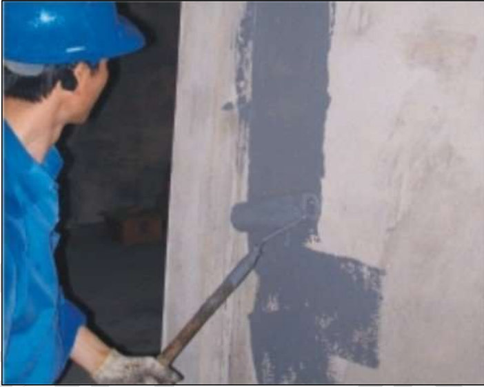
概要說明：外牆塗抹彈性水泥防水層
