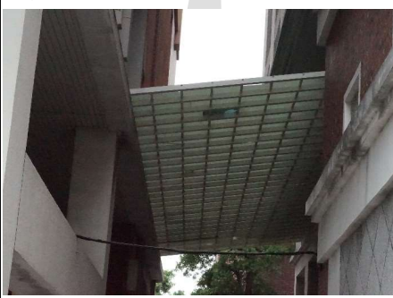
概要說明：弘學樓外牆現況
