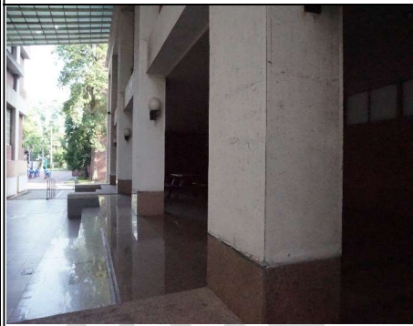
概要說明：弘學樓周邊柱面現況
